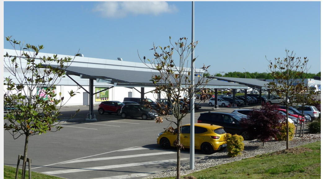
Ombrières à Saint-Junien
